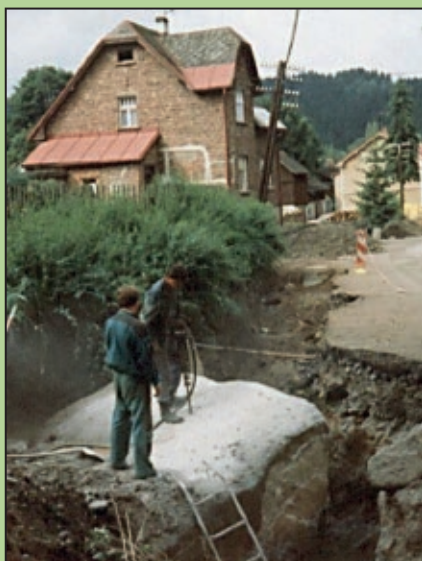
První výkop kanalizace u bývalé samoobsluhy 4. března 1998 a potíže s obrovským žulovým balvanem 17. července 1998 u dnešních retenčních nádrží (kronika obce Stříbrná)
